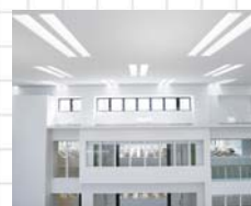
吹き抜け最上部の換気窓から自然な風を有効利用。
