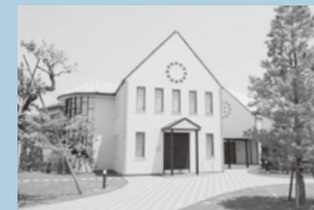
▲同窓会館外観。
